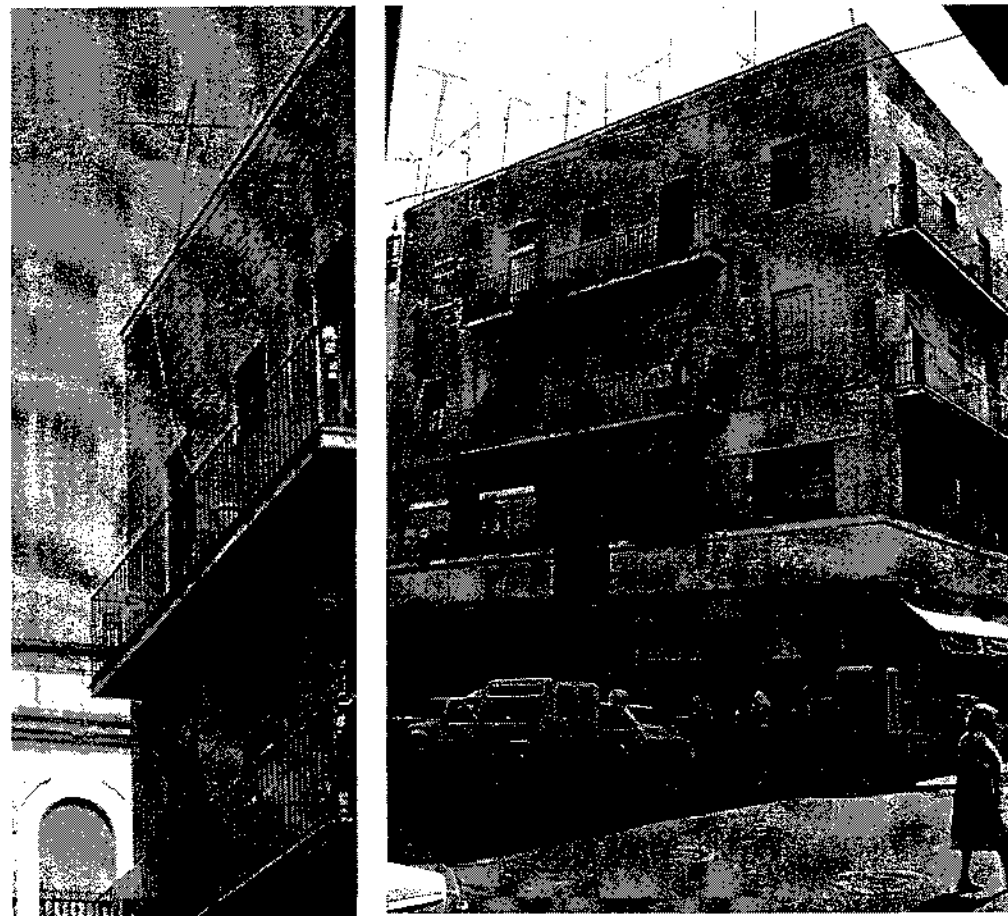
4.35. G. Lupiáñez y R. Arévalo. Casa en C/ Feria esquina a Relator
